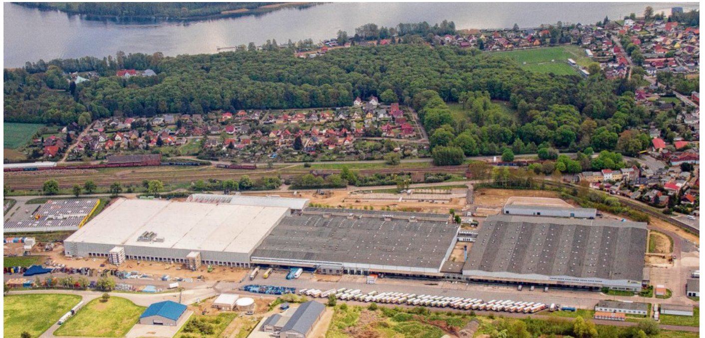
Die Außenhalle des neuen Edeka-Lagerkomplexes ist fertiggestellt.
