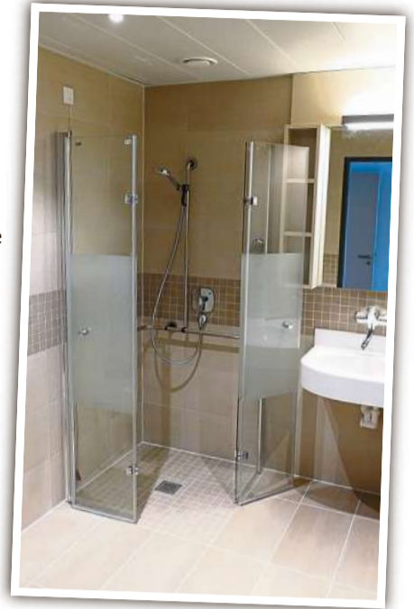
Bodengleiche Nasszelle in allen Patientenzimmern.
